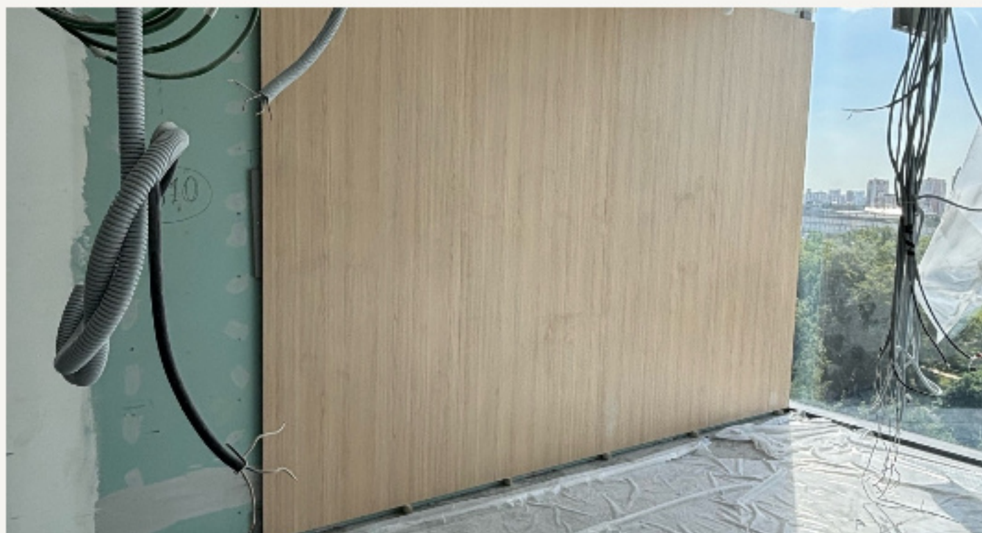
Монтаж стеновых панелей
