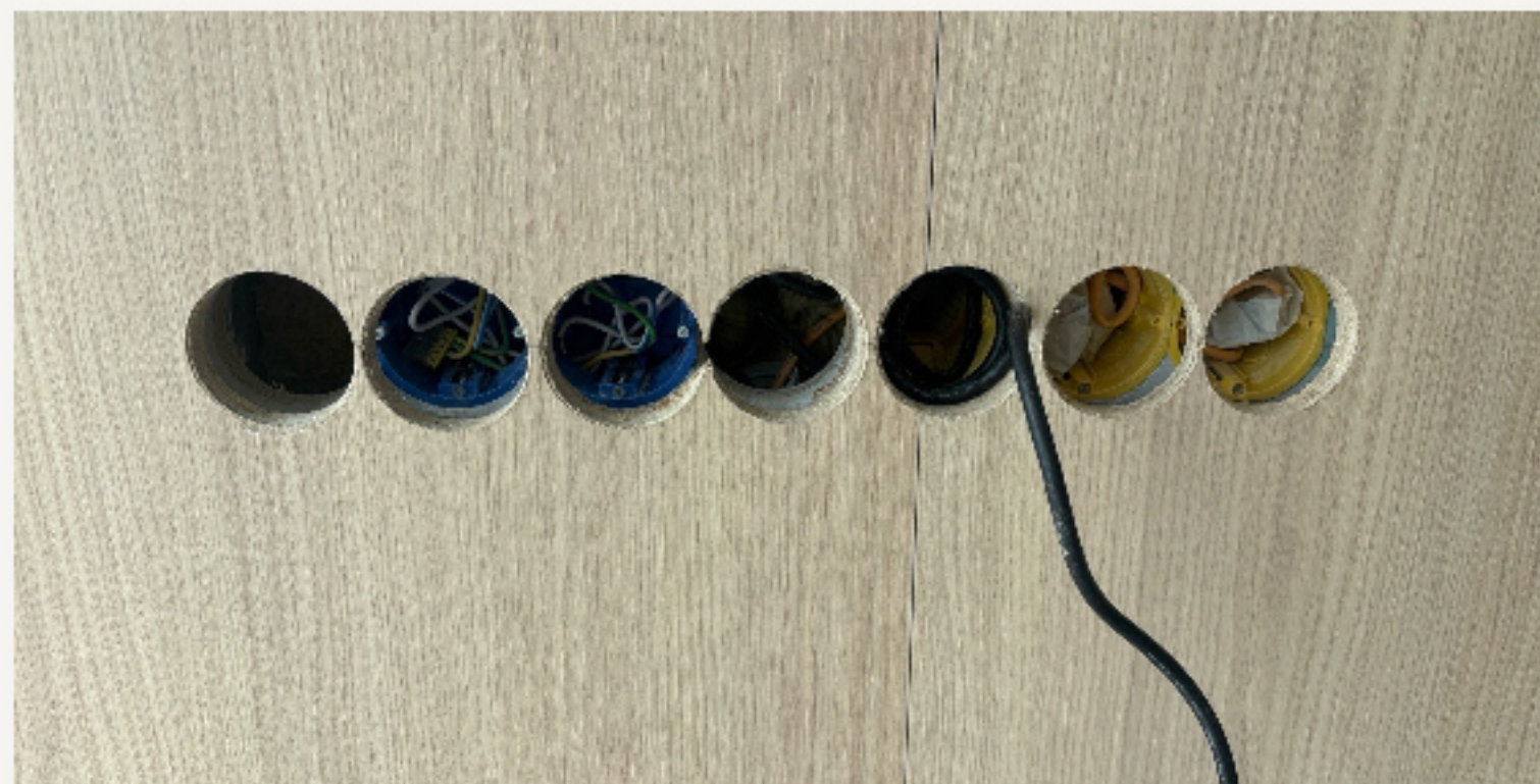
Подготовка отверстий под электрику
